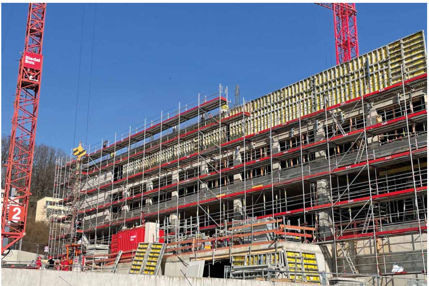
Der Rohbau ist weitgehend abgeschlossen und im Kostenrahmen.
