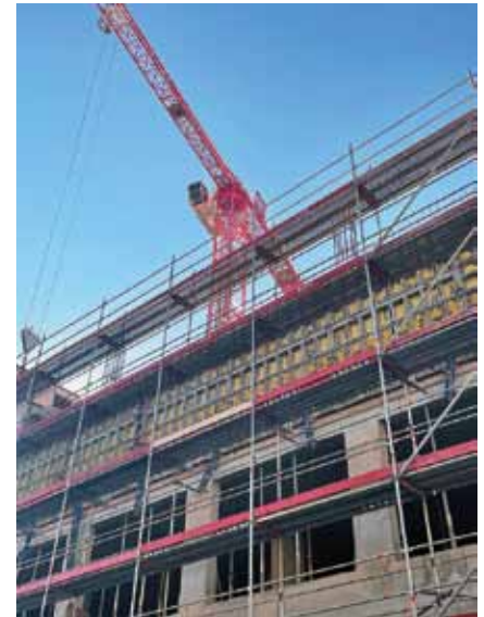
Kräne thronen über dem mächtigen Bauwerk.
