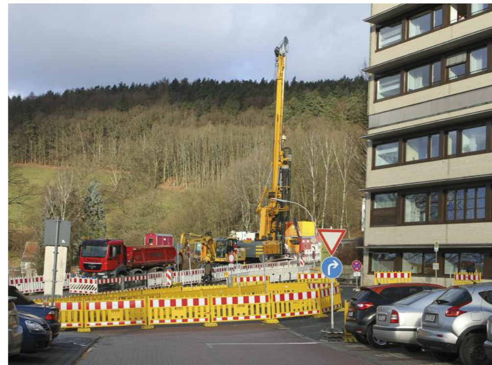
Behelfsmäßig mußte der Wendehammer unterhalb des Gebäudes angelegt werden.
