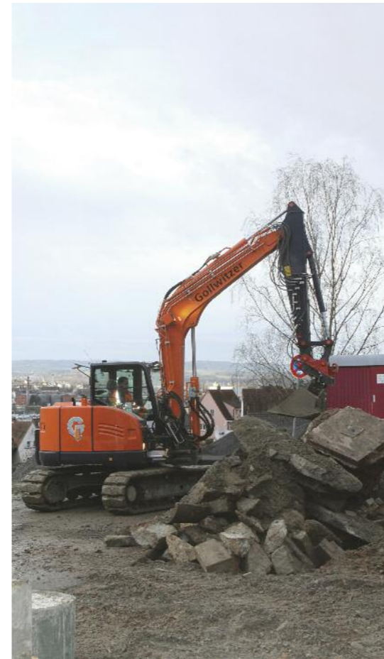
Umfangreiche Erdarbeiten sind nötig.
