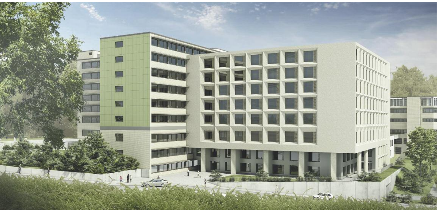
Der Neubau Süd des Klinikums ist fertiggestellt. So wird es aussehen, wenn auch die letzten Außenarbeiten abgeschlossen sind.
