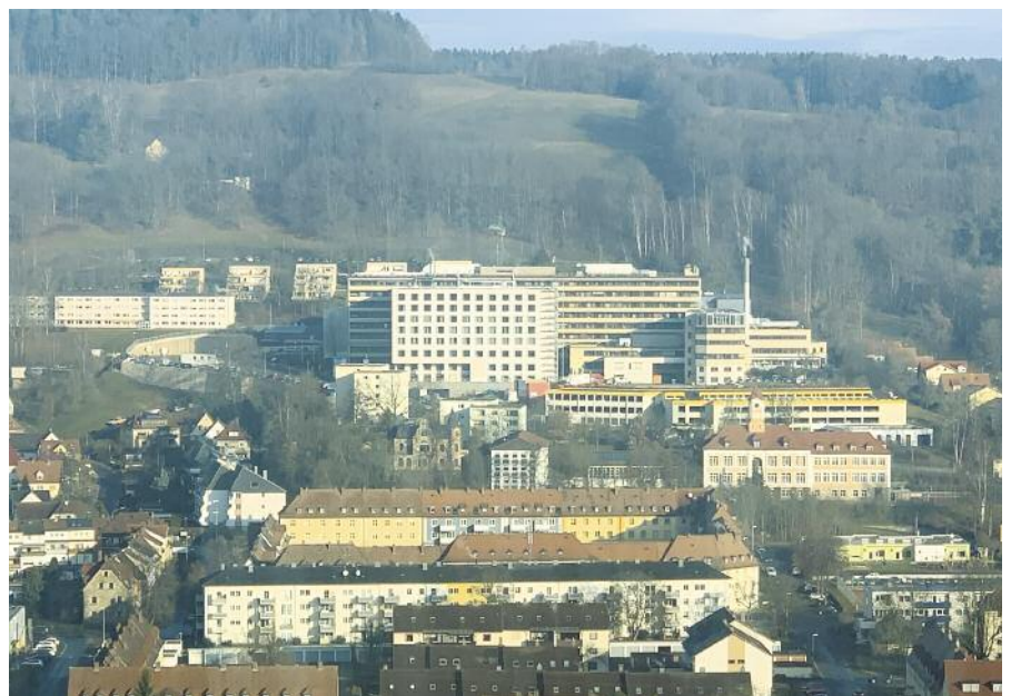
Der aktuelle Blick aufs Klinikum mit dem nun abgeschlossenen Neubau Süd von der Plassenburg aus.
