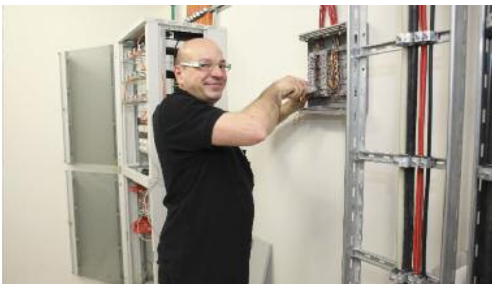
Markus Michale arbeitete an der Installation für die Brandmeldeanlage.
