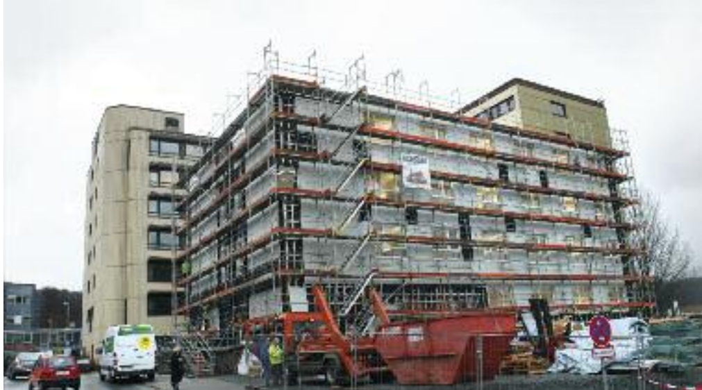
Auf der Baustelle des Interims-Bettengebäudes am Klinikum gab es über Wochen praktisch keinen Raum, in dem nicht gearbeitet wurde. Der Zeitplan war eng, wurde aber eingehalten.
