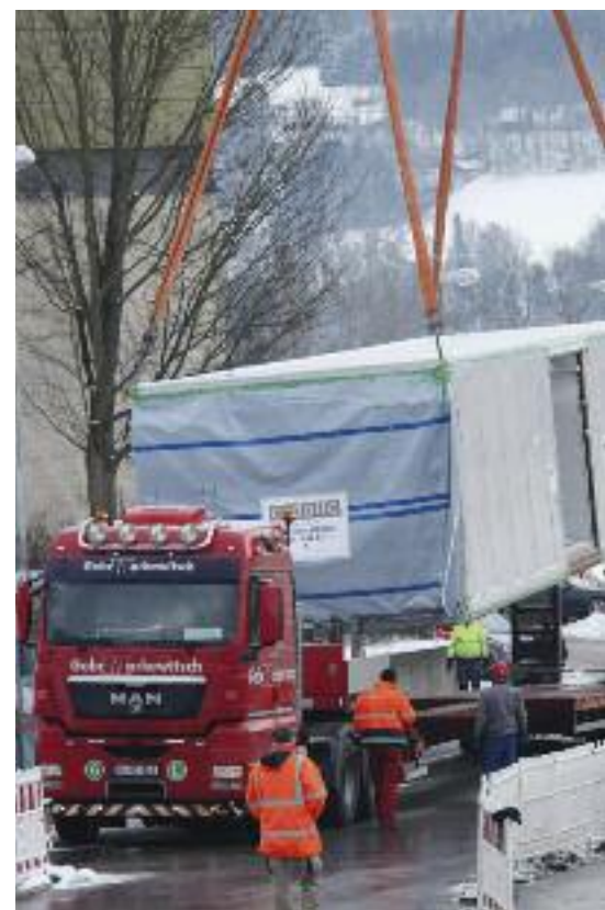
26 Bauteile wurden binnen weniger Tage angeliefert und aufgestellt
