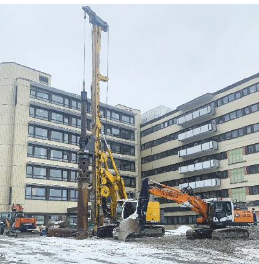
Die Baumaschinen standen schon im Januar bereit. Inzwischen sind auch schon die ersten Bohrpfähle gesetzt, auf denen dann von Mai an das neue Gebäude errichtet wird.
