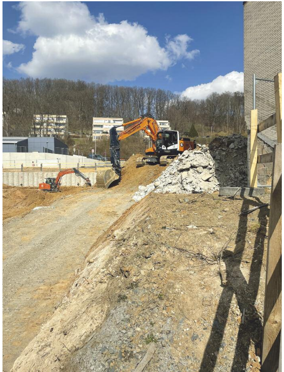
Die Bagger arbeiten bereits an der Baugrube.
