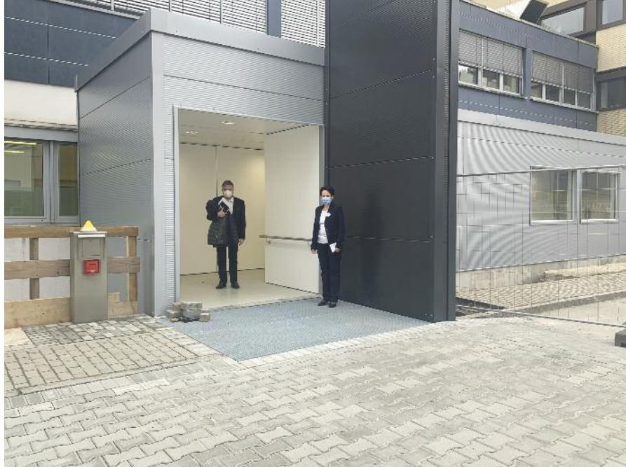
Landrat Klaus Peter Söllner und Geschäftsführerin Brigitte Angermann am neuen vorübergehenden Haupt- eingang des Klinikums Kulmbach. Der bisherige Eingang wird wegen der beginnenden Bauarbeiten ge- schlossen.
