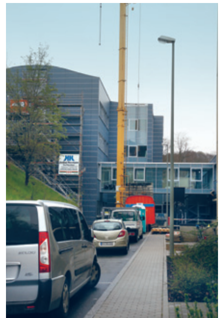
Noch steht ein Kran vor dem Eingang und der Zugang zur neuen Notaufnahme ist noch gesperrt.
