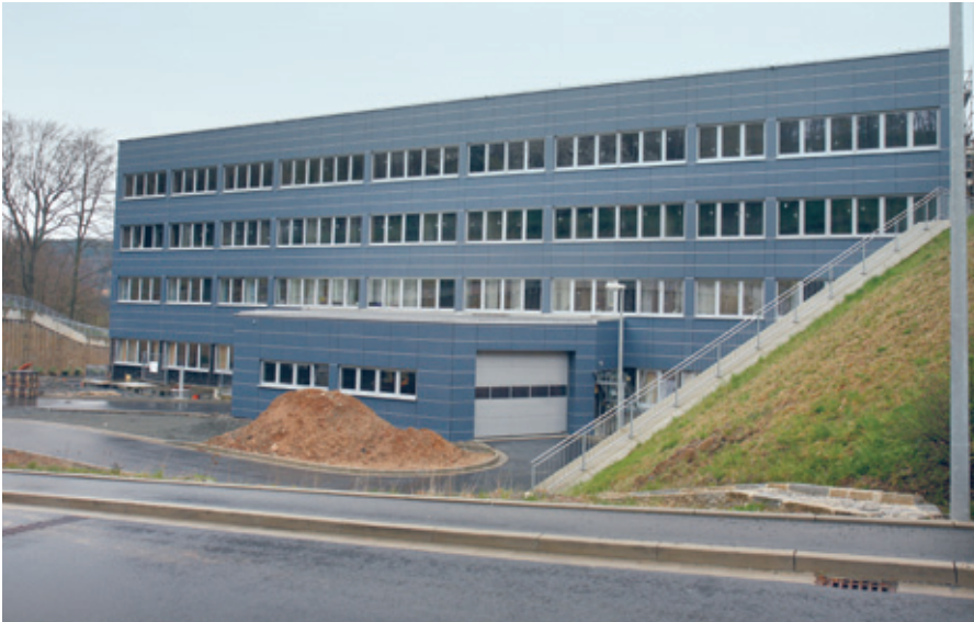
Ansicht von hinten: Der Anbau ist ein mächtiges Gebäude geworden. Ein neues Pathologisches Institut wird unter anderem dort einziehen.
