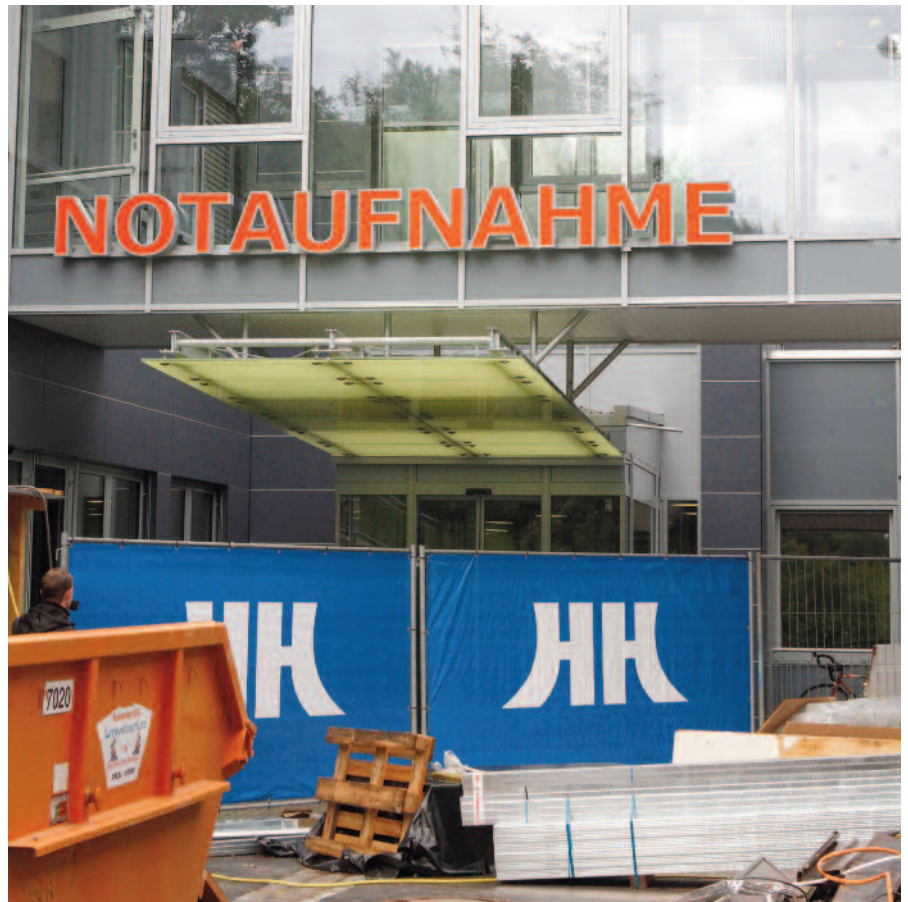
Noch ist vor dem Eingang Baustelle, aber auch dieser Abschnitt geht bald zu Ende und dann wird der Neubau ohne Behinderungen zugänglich sein.
