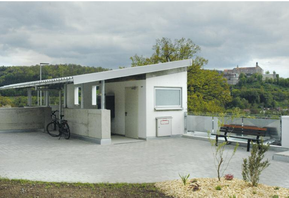
Kassenautomat und Eingang zu den in den Hang gebauten Parkdecks.
