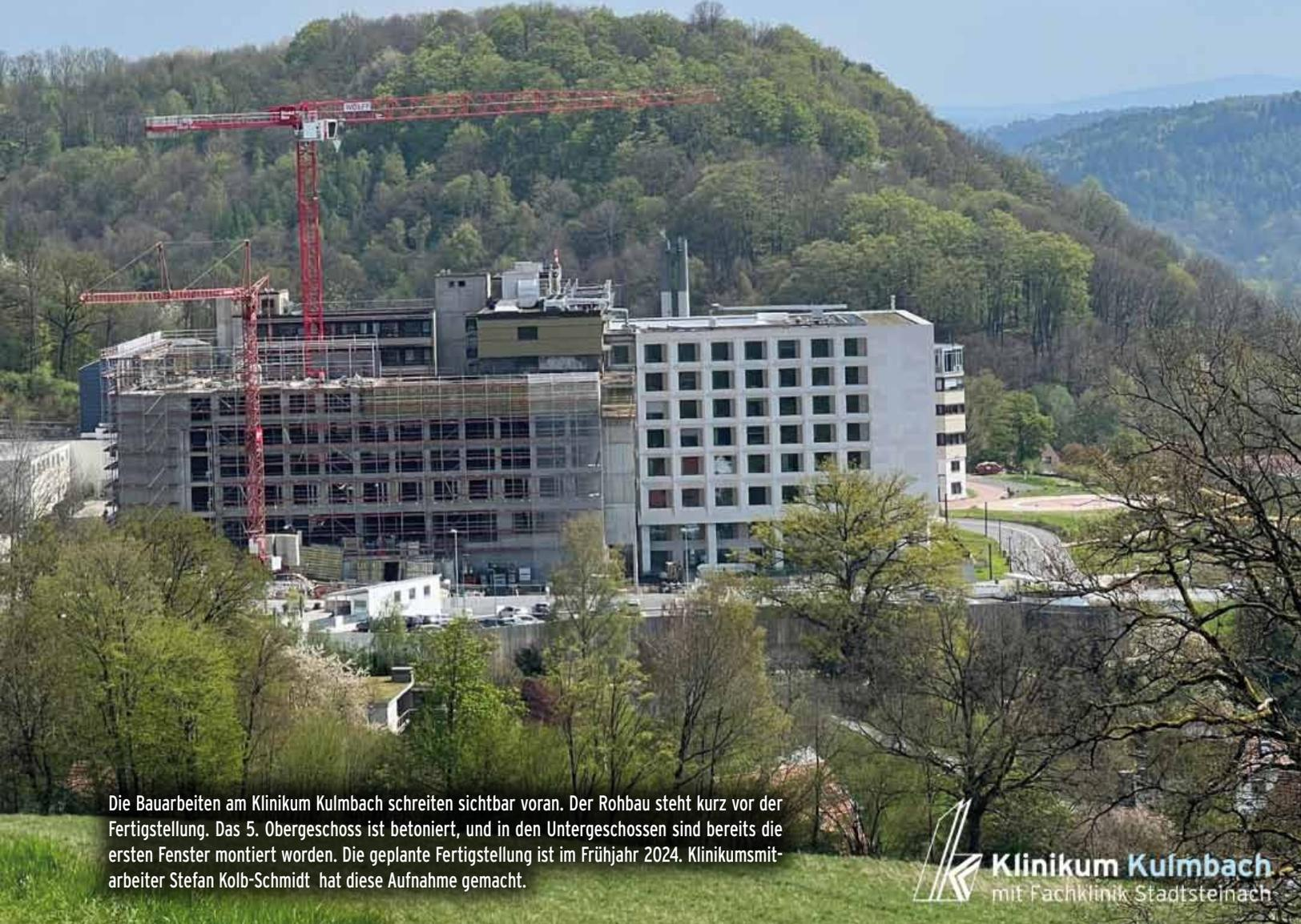
Die Bauarbeiten am Klinikum Kulmbach schreiten sichtbar voran. Der Rohbau steht kurz vor der Fertigstellung. Das 5. Obergeschoss ist betoniert, und in den Untergeschossen sind bereits die ersten Fenster montiert worden. Die geplante Fertigstellung ist im Frühjahr 2024. Klinikumsmitarbeiter Stefan Kolb-Schmidt hat diese Aufnahme gemacht.
