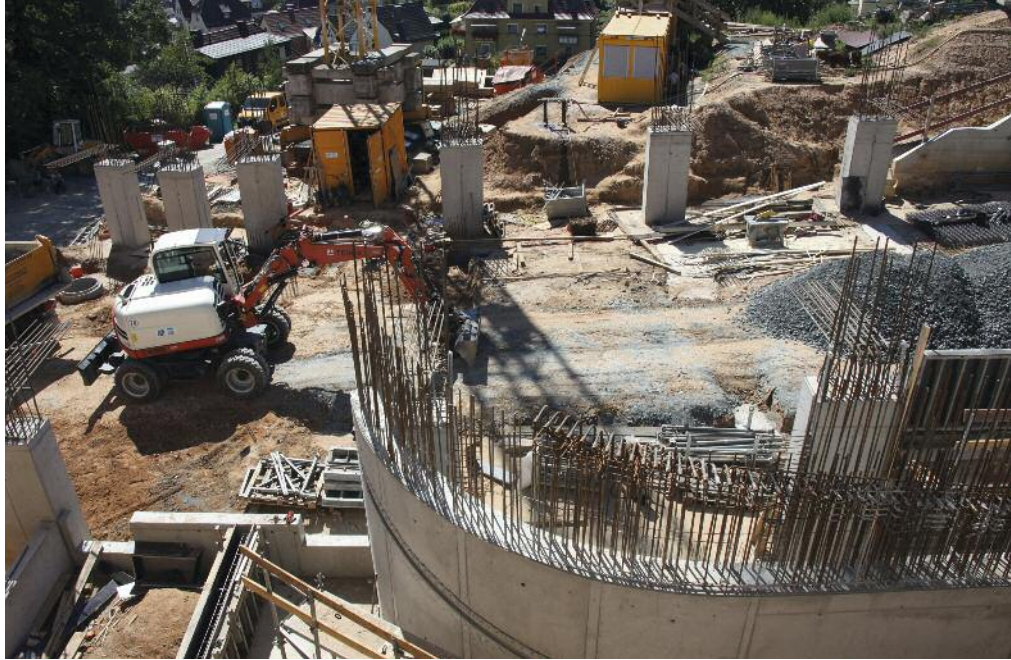
Gewaltige Mengen von Beton werden ins neue Parkhaus verbaut.
