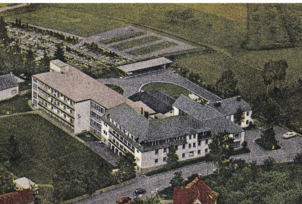
Eine Luftaufnahme des Kreiskrankenhauses um 1970, das seit 1995 zum Zweckverband Klinikum Kulmbach gehört und dort die Fachklinik Stadtsteinach mit ihrer Geriatrischen und Orthopädischen Rehabilitation, der Akutgeriatrie und der Inneren Medizin betreibt.
