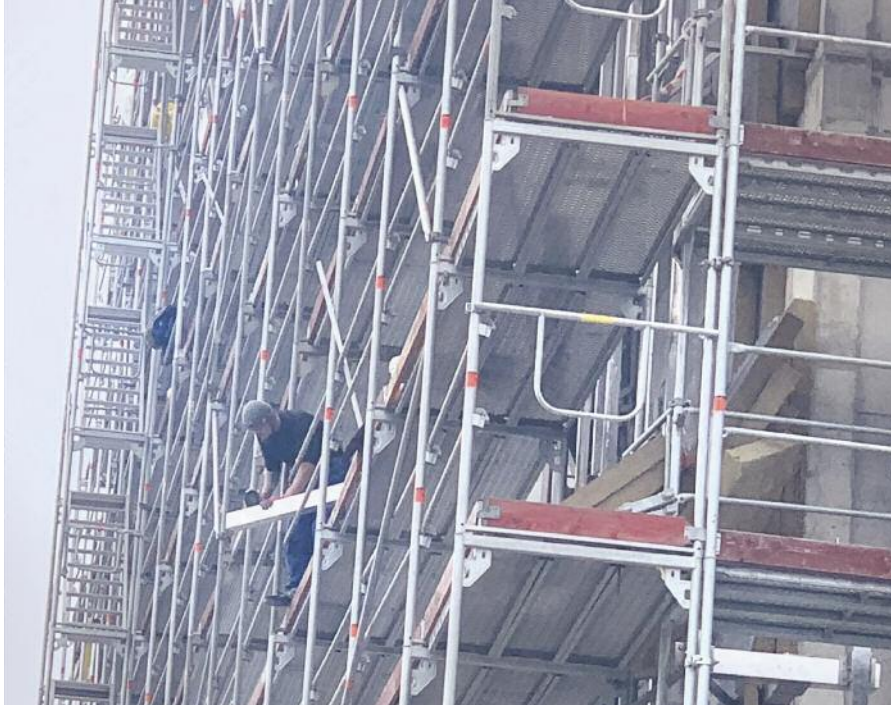
Mit Hochdruck wird auch an der Fertigstellung der Fassade gearbeitet, die mit Natursteinen verkleidet wird.
