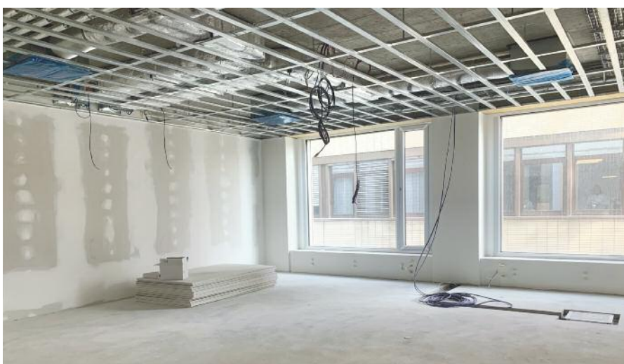
Auch große Konferenzräume sind im Neubau untergebracht.
