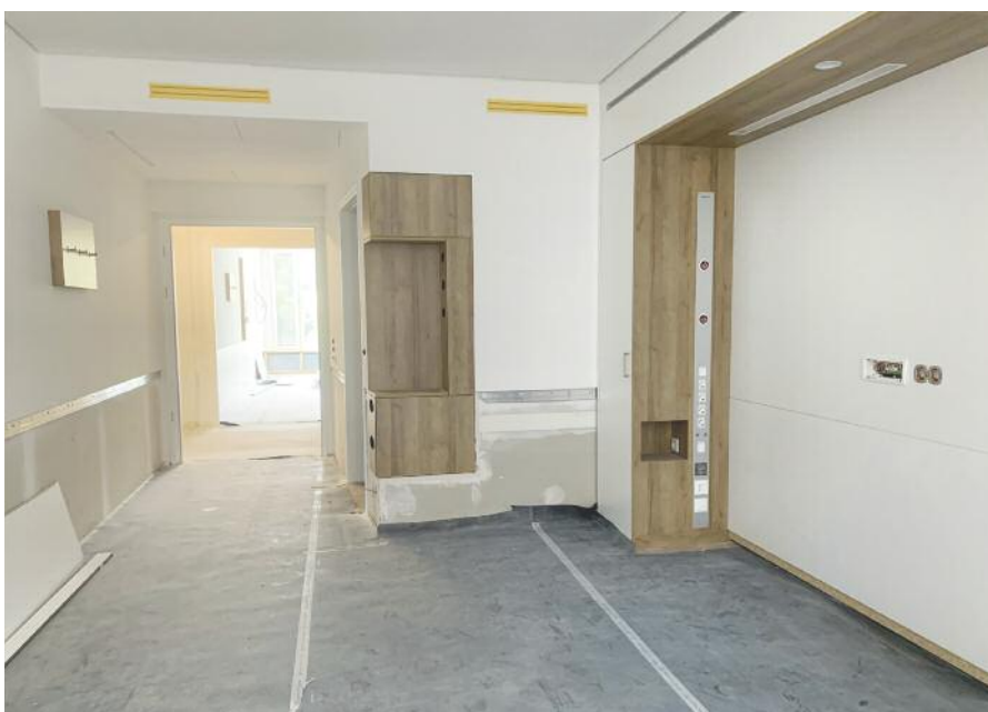
Die Patientenzimmer werden künftig Zweibettstandard haben. Für die Ausstattung hat das Klinikum unter anderem auf warme Holzöne gesetzt. Der Innenausbau ist bereits im vollen Gange.
