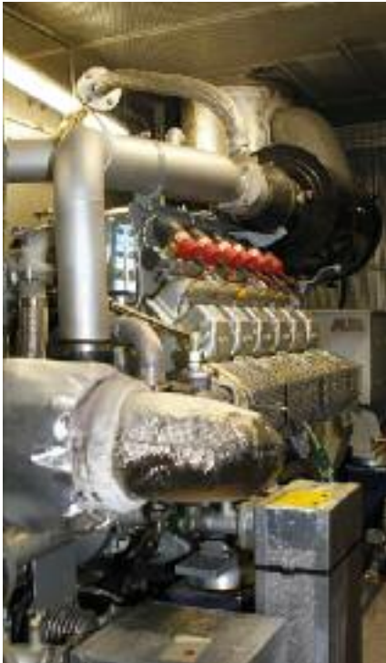
Das Klinikum Kulmbach betreibt im zweiten Untergeschoss ein eigenes Blockheizkraftwerk. Auch dies stellt einen Beitrag zur Energieeinsparung dar.
