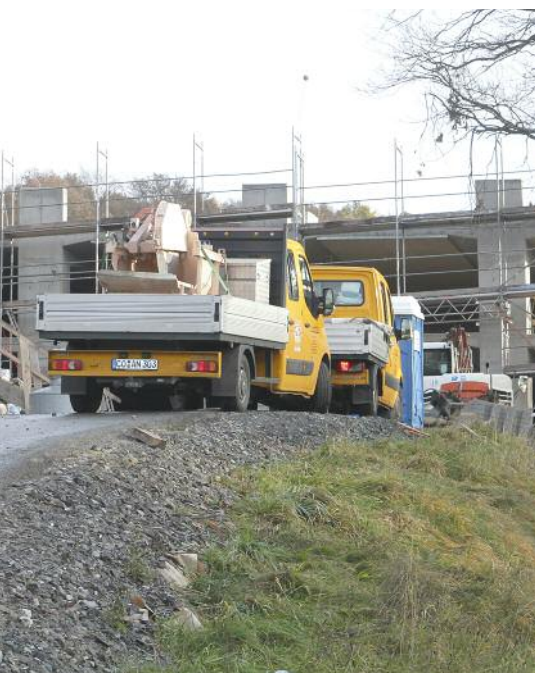
Behelfsmäßig führt eine Baustellenstraße in den Hang.
