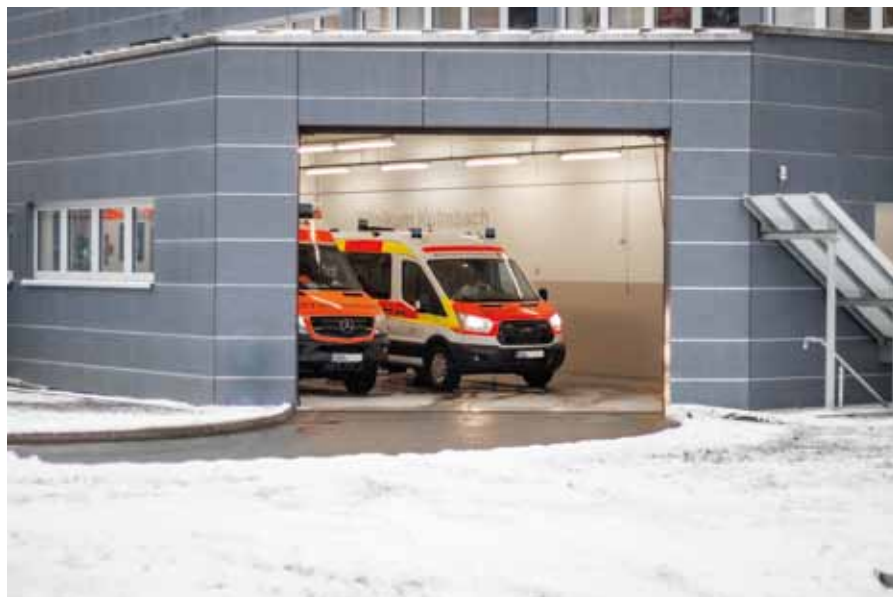
Rettungswagen, die das Klinikum Kulmbach anfahren, bringen Patienten über eine Halle direkt in die Notaufnahme.
